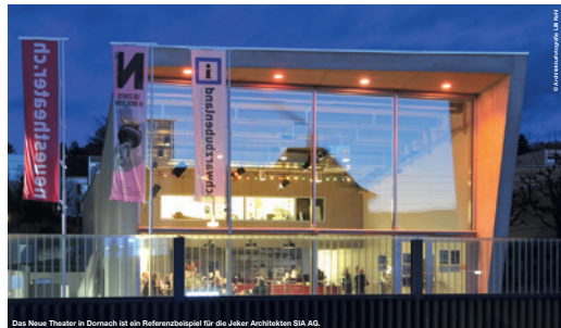
Das Neue Theater in Dornach ist ein Referenzobjekt für die Jeker Architekten SIA AG.
