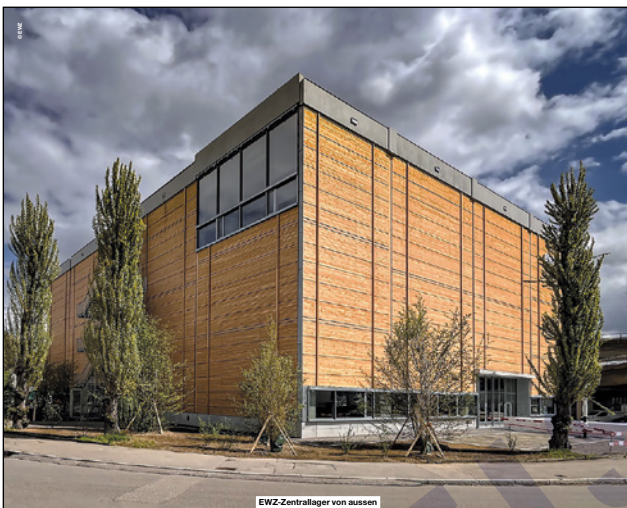
EWZ-Zentrallager von aussen
