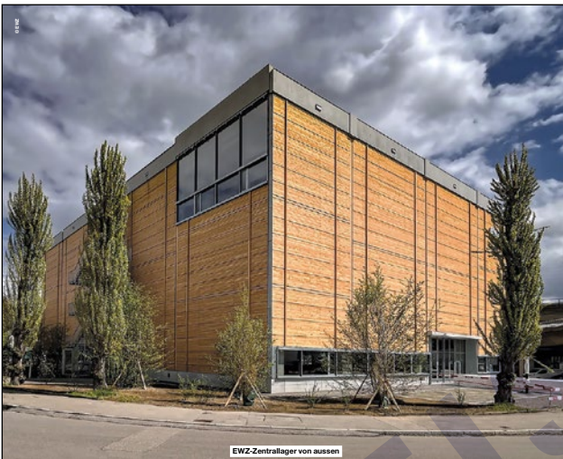
ewz-Zentrallager von aussen
